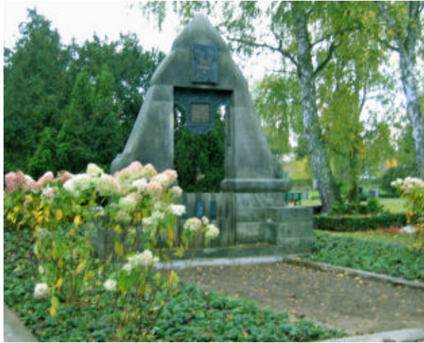
Die restaurierte Anlage im Oktober 2009
